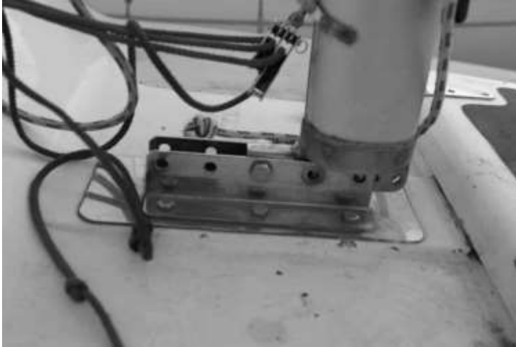
Fig. 2 Deze mast staat te ver naar voren in het mastspoor
